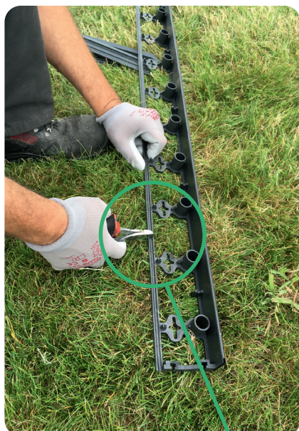
Préparation rapide d'une forme courbe en découpant les renforts à la simple pince coupante
